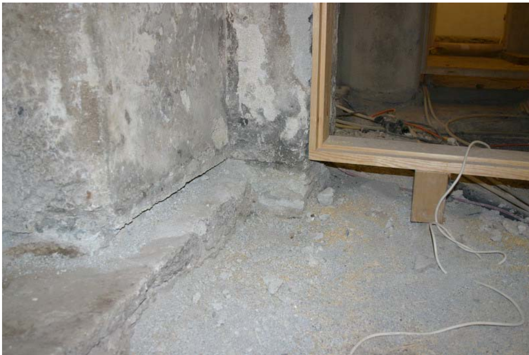
Mynd 8. För eftir gólfborð í stofuvegg til vinstri við dyraop (GÓL2006-13-12).
