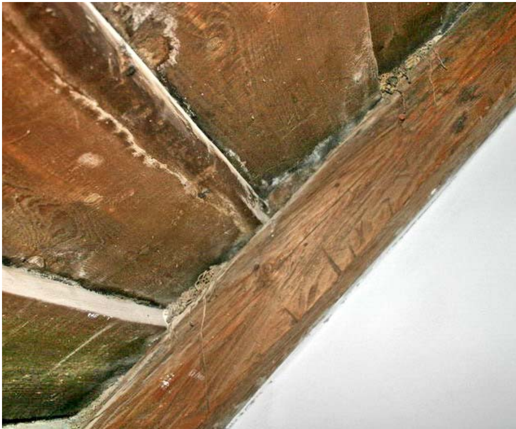
Mynd 22. Nærmynd af netadræsnum í bili milli skarsúðar og sperru (GÓL2006-13-38).
