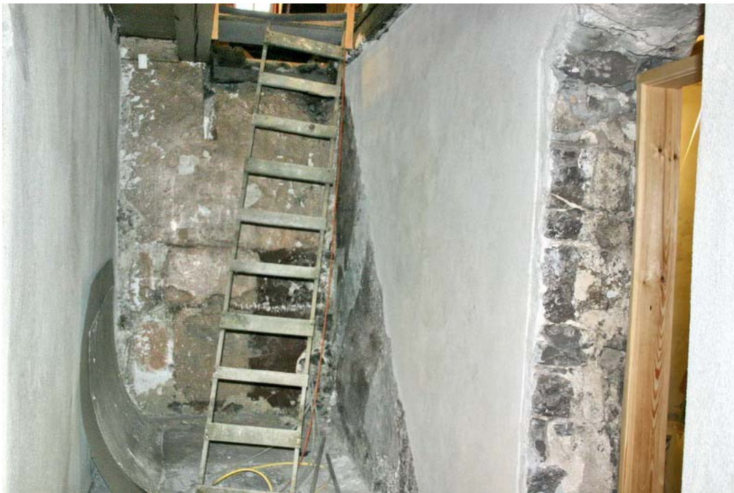
Mynd 6. Horft inn í forstofu. Á veggnum til hægri sjást för eftir stigann upp á efri hæð. Viðgerður veggur og hluti af dyrakarmi inn í stofu er til vinstri (GÓL2006-13-9).
