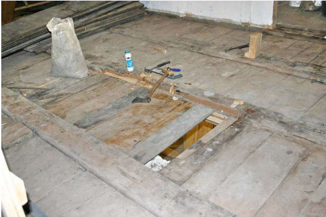
Mynd 14. Upptekið gólf í framlofti (204) að suðaustanverðu. Verið er að setja neðriborð sem vantaði í bil milli gólfbita (GÓL2006-13-23).
