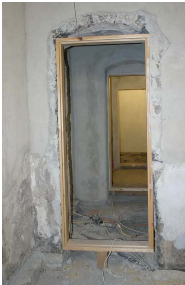
Mynd 8. För eftir gólfborð í stofuvegg til vinstri við dyraop (GÓL2006-13-12).
