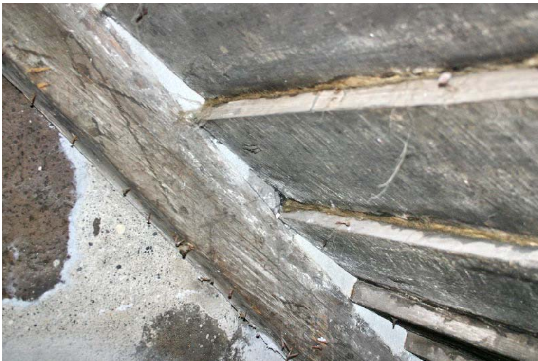
Mynd 26. Nærmynd af viðgerð á múrfyllingu í glufum milli sperru og skarsúðar við norðausturgafli. Ljósá múrfyllingin er ný, sú dökka er gömul. (GÓL2006-13-34).
