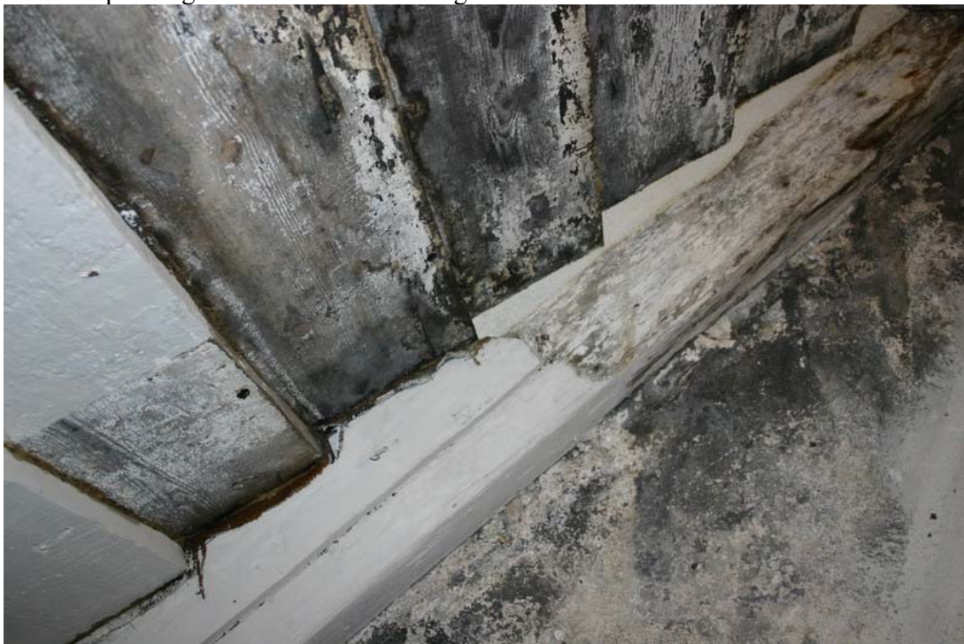
Mynd 12. Nærmynd af múr í glufum milli sperru og skarsúðar GÓL2006-13-17)
