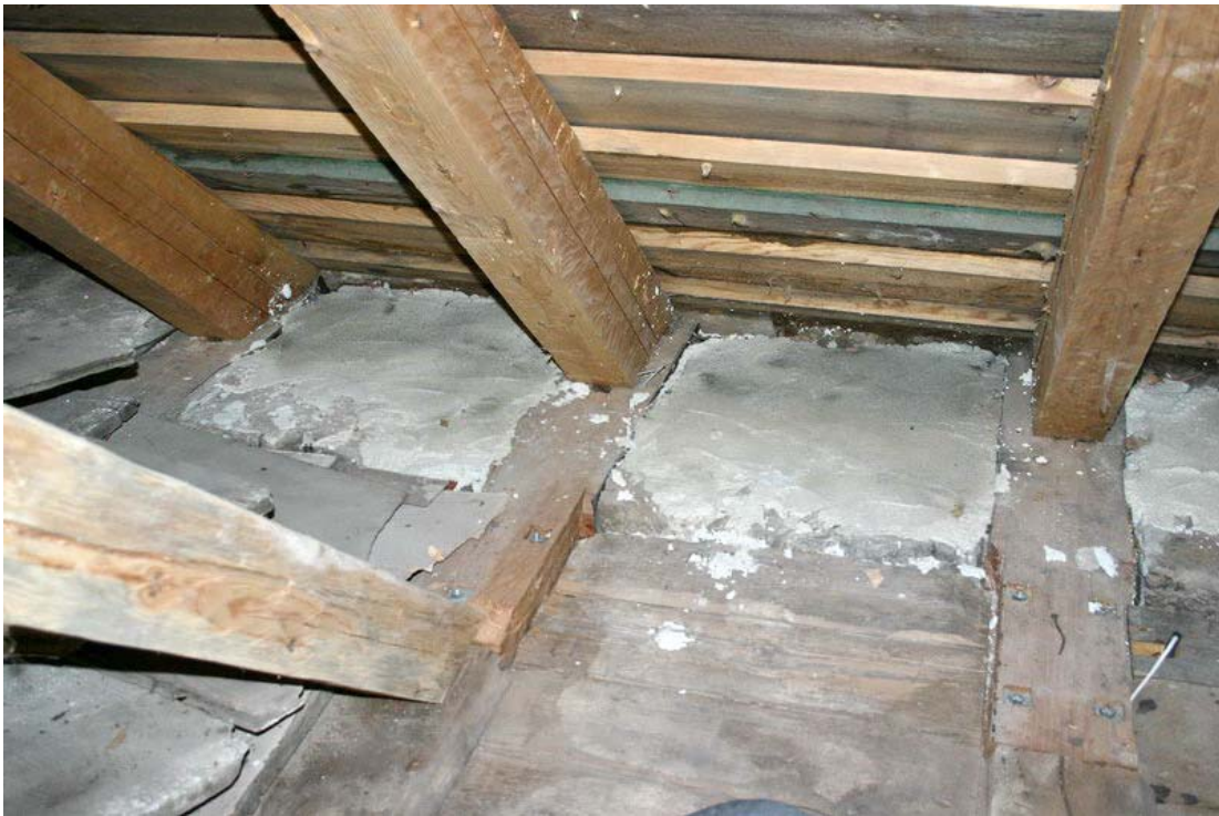
Mynd 17. Skarsúð og nýir endar á loftbitum á austurhlið framlofts 204 (GÓL2006-13-27).
