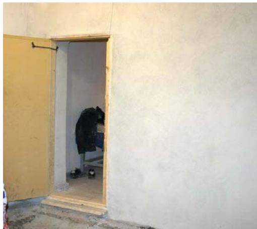
Mynd 2. Dyrakarmur í vegg milli svefnherbergis og skoðunarherbergis (GÓL2006-13-1).
