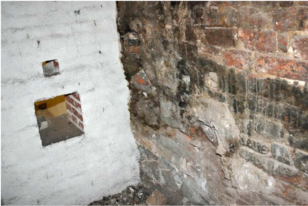
Mynd 4. För í vegg eftir rör úr eldstæði að bileggjaraofnum (GÓL2006-13-6).
