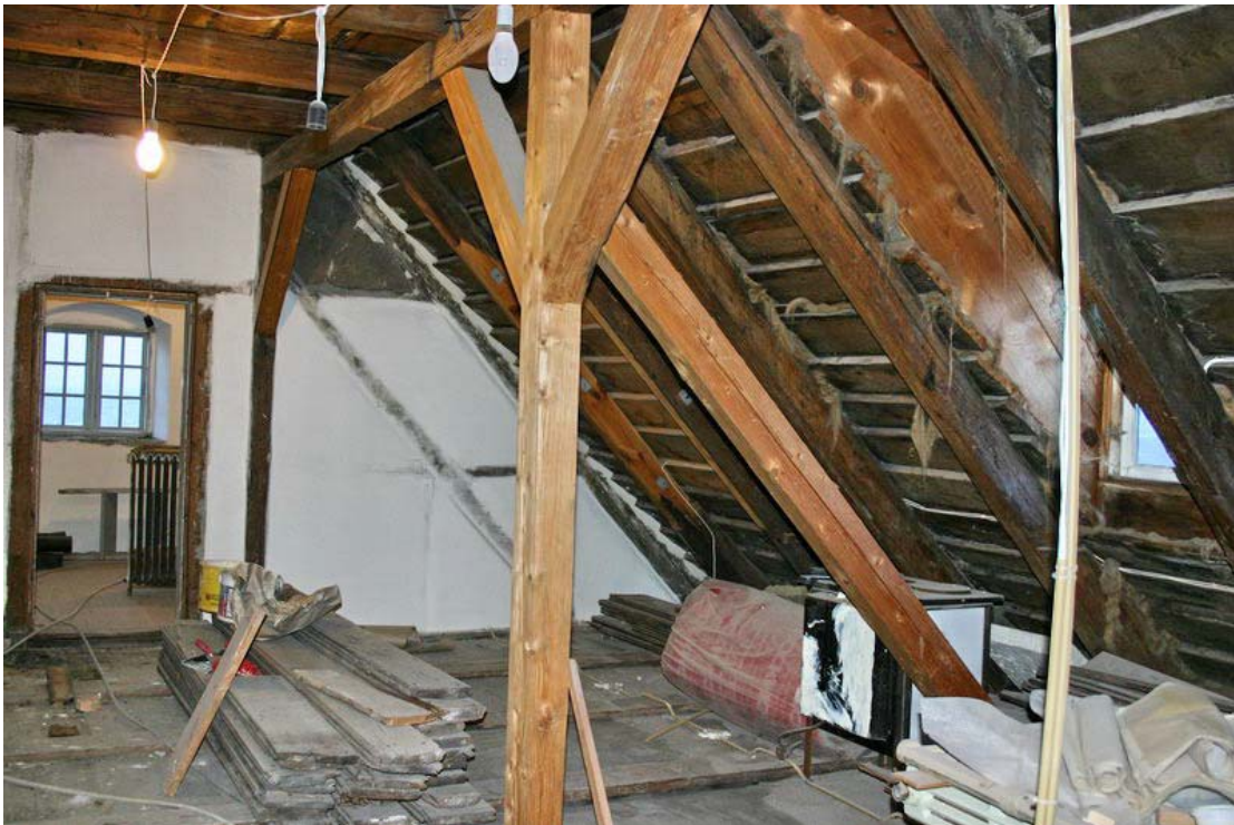
Mynd 20. Burðarstoðir og nýjar skástífur á vesturhluta framlofts (GÓL2006-13-36).
