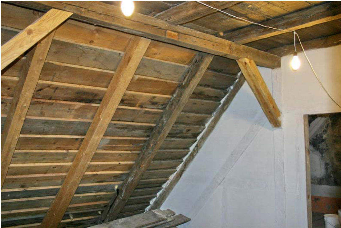
Mynd 15. Þakið að austanverðu og nýjar skástífur á framlofti 204 (GÓL2006-13-24).
